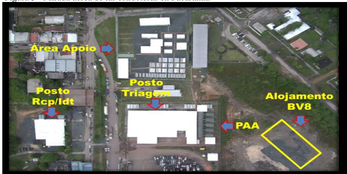
Figura 5 - Mirada aérea de las estructuras en Pacaraima
